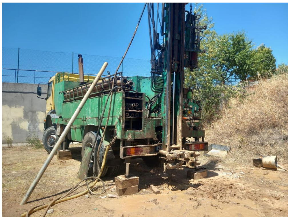
Figura Nº 6.- Imagen de la ejecución del sondeo mecánico y rotativo con extracción continua de testigo referido como S-01.
